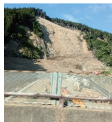
石川県輪島市
