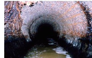
古い下水道管渠
