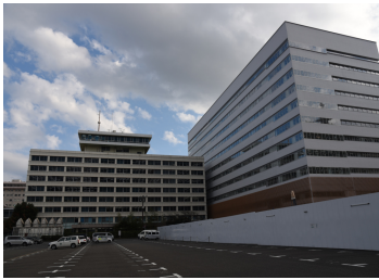
左-本庁舎、右-間もなく完成の新庁舎
