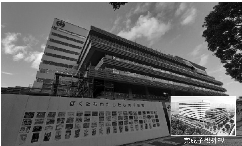
もうすぐ完成の千葉市役所新庁舎 R5年6月全面利用開始予定
