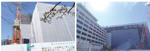
建設中の新庁舎 (R4.3月)
